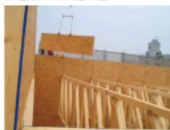
⑧ クモ筋交い・振れ止め取り付け
