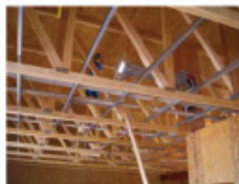
⑧ クモ筋交い・振れ止め取り付け
